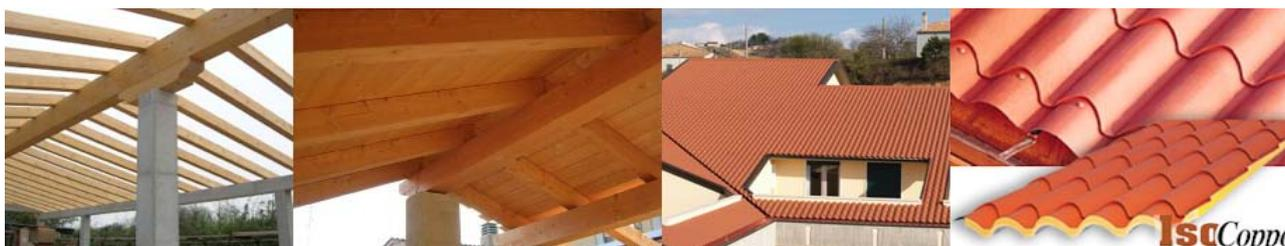
Il tetto sarà in legno lamellare, a falde inclinate, con travi e perline a vista dello spessore di 2,5 cm.
